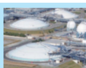
LNG地下タンク LNGを貯蔵します。耐震性にすぐれた地下タンクであるため、万一、亀裂などが生じてもLNGが漏れない構造になっています。
